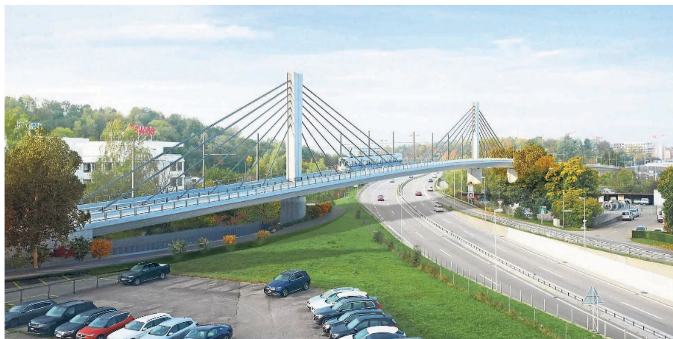
Wegen der Vorgaben des Bundesamtes für Strassen, das keine Pfeiler auf der Autobahn will, ist die Brückenkonstruktion aufwendig. VISUALISIERUNG ARCHITRON
