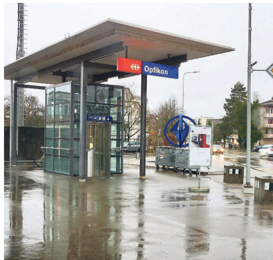
Der Lift an der Schaffhauserstrasse ist zu klein und wird komplett ersetzt.
