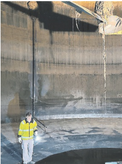
30 Jahre lang in Betrieb: Blick in den alten Faulturm vor seiner Sanierung.
