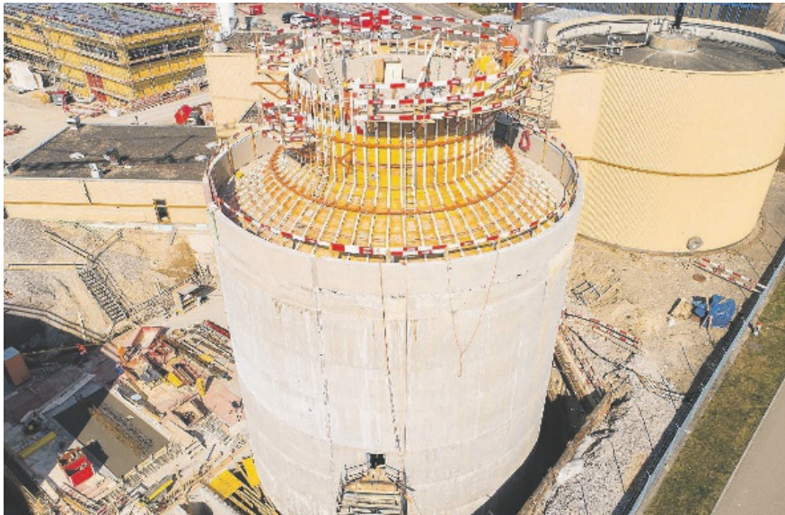
Einer der beiden neuen Faultürme im Rohbau. Rechts davon der alte Faulturm, der neu als Stapelbehälter genutzt wird.
