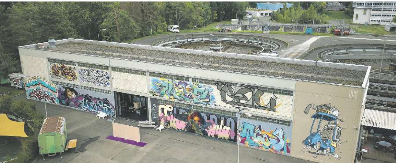
Die Gebläsehalle trennt den seit Jahren ungenutzten Teil der ehemaligen ARA Glatt ab. Die Brücke über dem rechten Becken bleibt bestehen.
