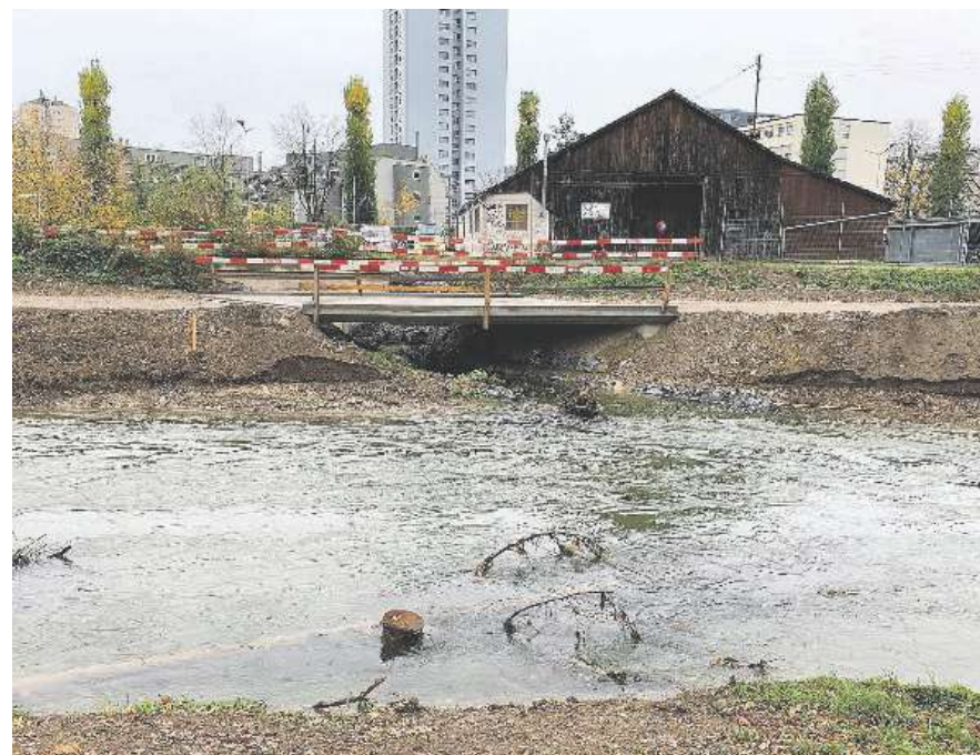
Die neue Brücke für den Uferweg bei der Einmündung des Hirzenbachs.
