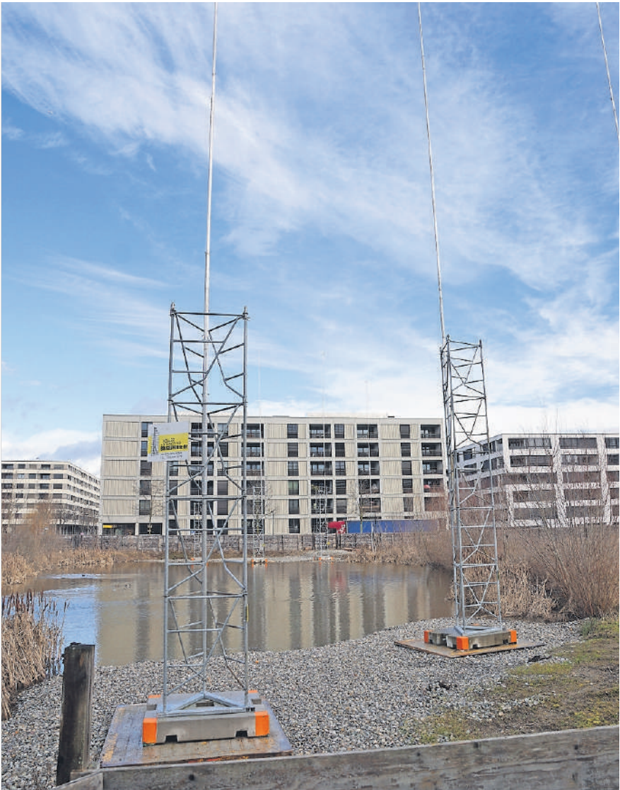
Das Baugespann fürs Schulhaus Glattpark soll diesmal nicht umsonst aufgestellt worden sein.
