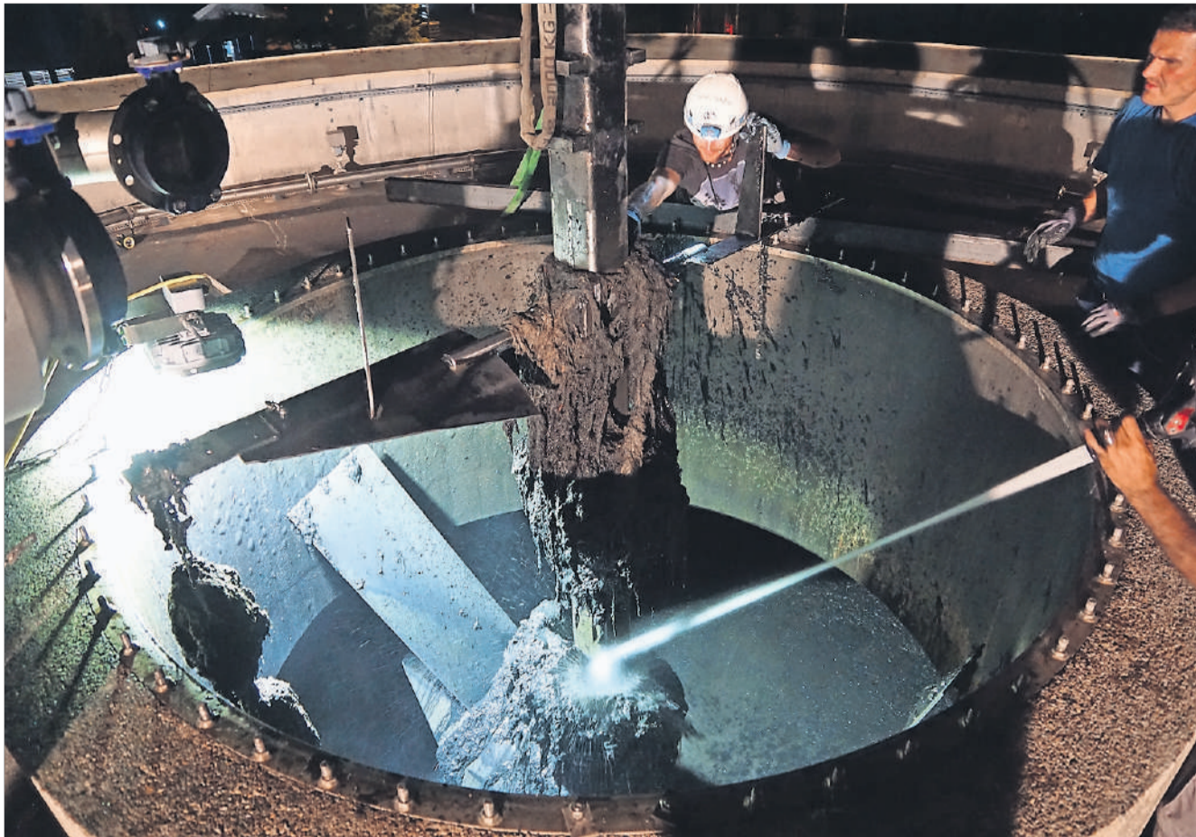
Weil sie sich nicht auflösen, kleben kiloweise Haare von 17 Jahren Rühren am Rotor.
